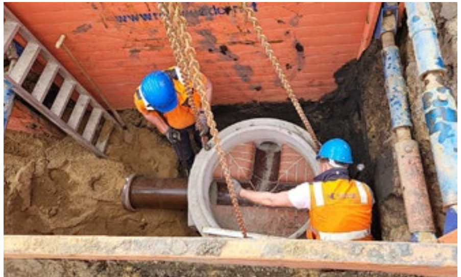
Ausbau eines Kanalschachtes an der Kreuzung Steinstraße/Kommissionsstraße..
