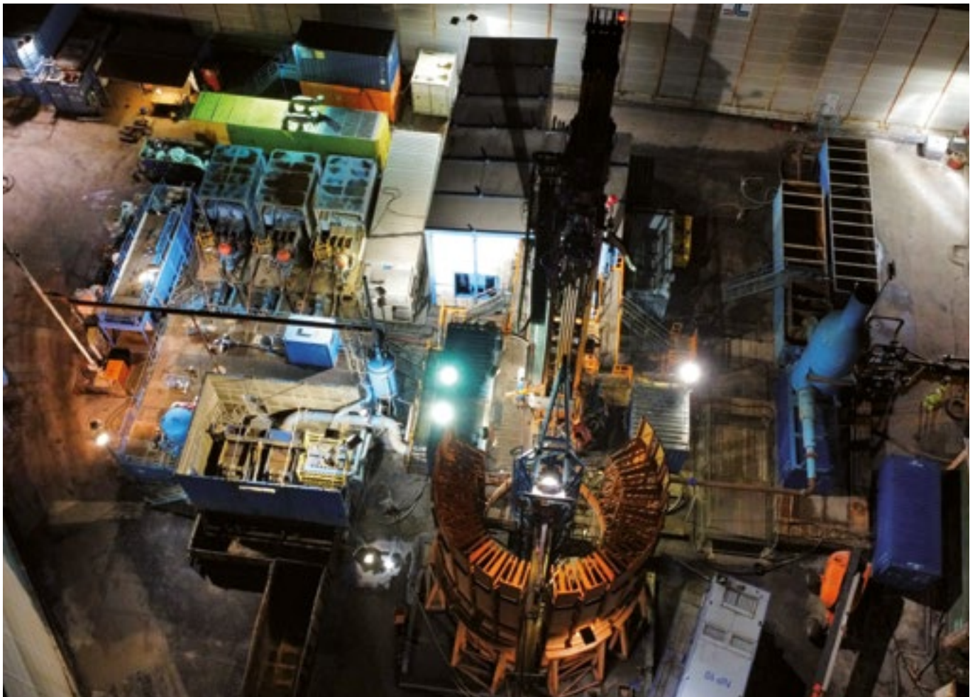
Während der Geothermiebohrung. Gearbeitet wurde rund um die Uhr.
