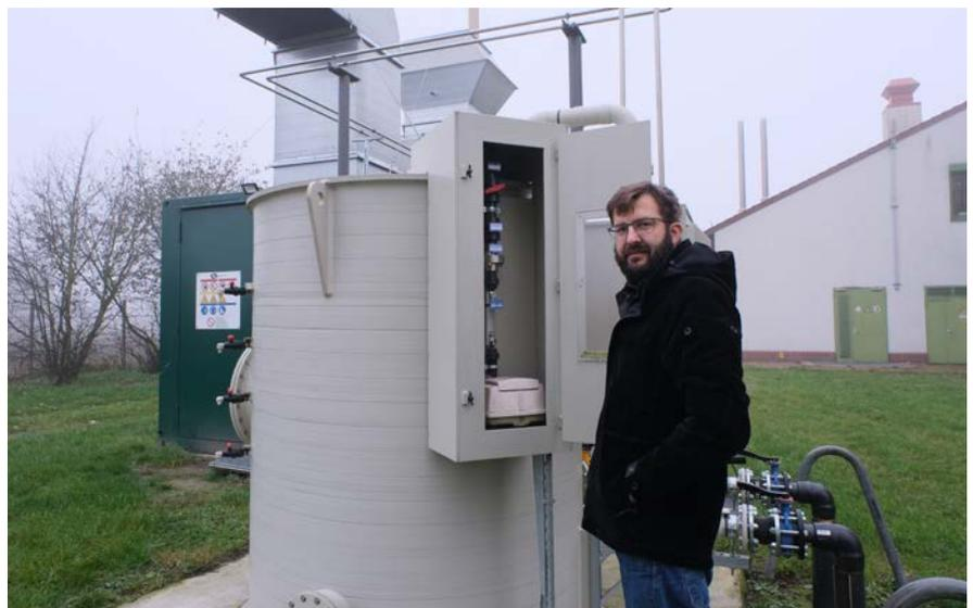
■ Alexander Kaesche vor dem Aktivkohlefilter des modernen Blockheizkraftwerks (BHKW) an der Neuruppiner Kläranlage. Hier wird aus Klärgas Strom und Wärme gewonnen.
