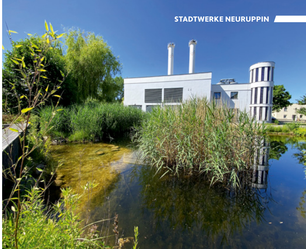
■ Grüne Energie: Moderne Blockheizkraftwerke wie das auf dem Gelände der Neuruppiner Stadtwerke sind der Schlüssel für eine klimafreundliche Heizwärme.
