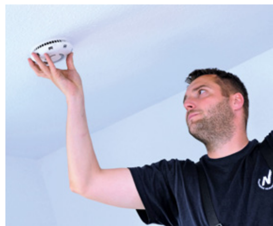
Christian Hein von den Neuruppiner Stadtwerken installiert einen der neuen Funkrauchwarnmelder, für deren Wartung und Überprüfung niemand mehr die Wohnung betreten muss.
