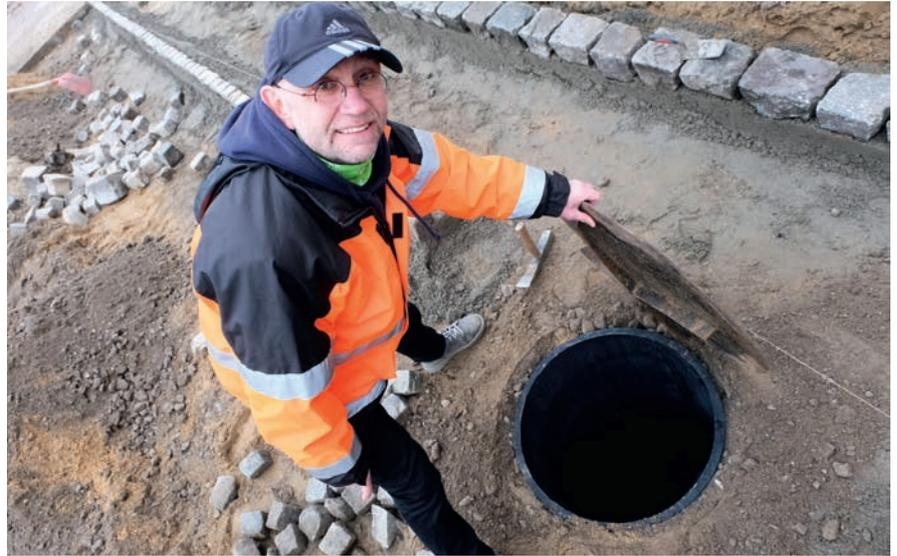
■ Tief unten: Torsten Maeles von den Neuruppiner Stadtwerken zeigt den Schacht, durch den das Regenwasser zu der Reinigungsanlage fließt.
