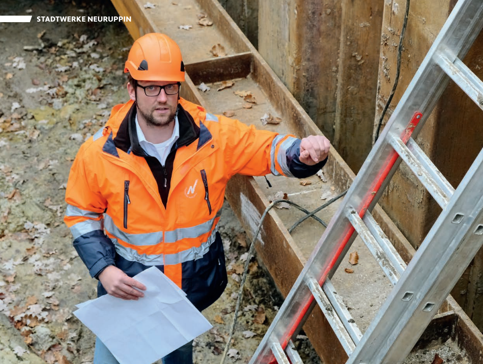
■ Vor dem Durchbruch: Erik Jeché ist Projektleiter für die Verbindung der zwei Fernwärme-Teilnetze der Stadtwerke Neuruppin.
