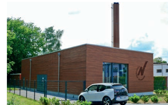
■ Die modernen Blockheizkraftwerke der Neuruppiner Stadtwerke – hier das in der Trencmannstraße – sind entscheidend für Energieeinsparungen in Größenordnungen.
