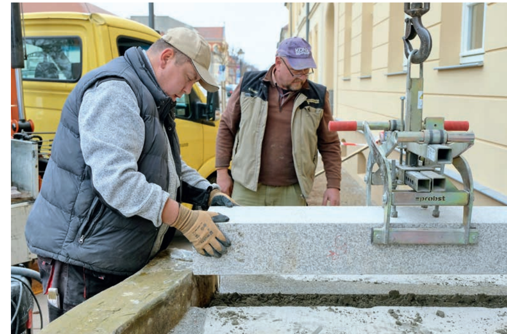
■ Mario Zschäge und Wojciech Charosewicz von der Firma Naturstein Pohlmann aus Wittstock passen die neuen, 200 Kilogramm schweren Granitstufen in die restaurierte zweiflügelige Treppe in der Engelsstraße 27 ein.
