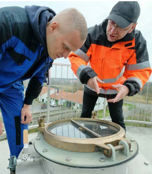
■ Alles im Fluss: Florian Geißler (l.) wird zur Fachkraft für Abwassertechnik bei den Neuruppiner Stadtwerken ausgebildet. Abwassermeister Torsten Maeles vermittelt ihm das entsprechende Know-how.
