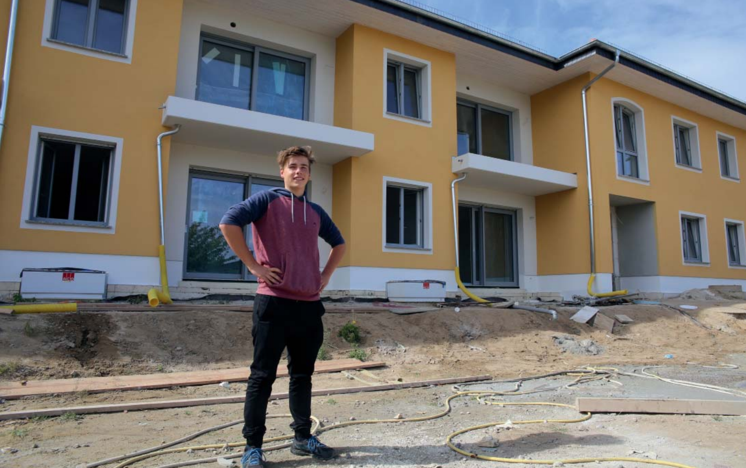
WBG-Mitglied Eugen Bergner bei der Baustellenbesichtigung „An der Weide“ 21.
