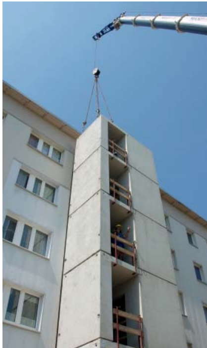
Aufzugschacht aus Fertigelementen.
