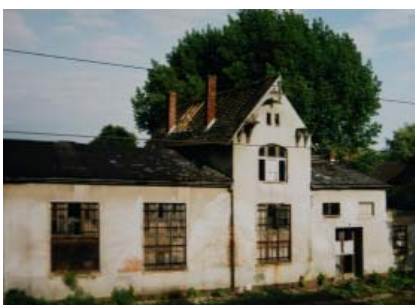
Der Seegarten vor der Sanierung ...
