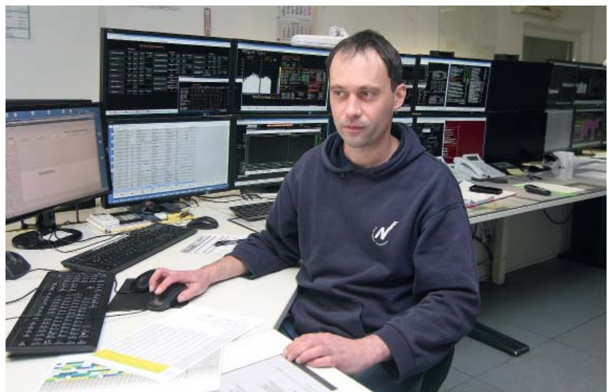
Kai-Uwe Krüger sorgt in der Netzleitstelle für die Versorgungssicherheit.
