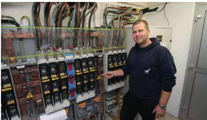
Stadtwerke-Elektromeister Daniel Rütz in der unterirdischen Trafostation.
