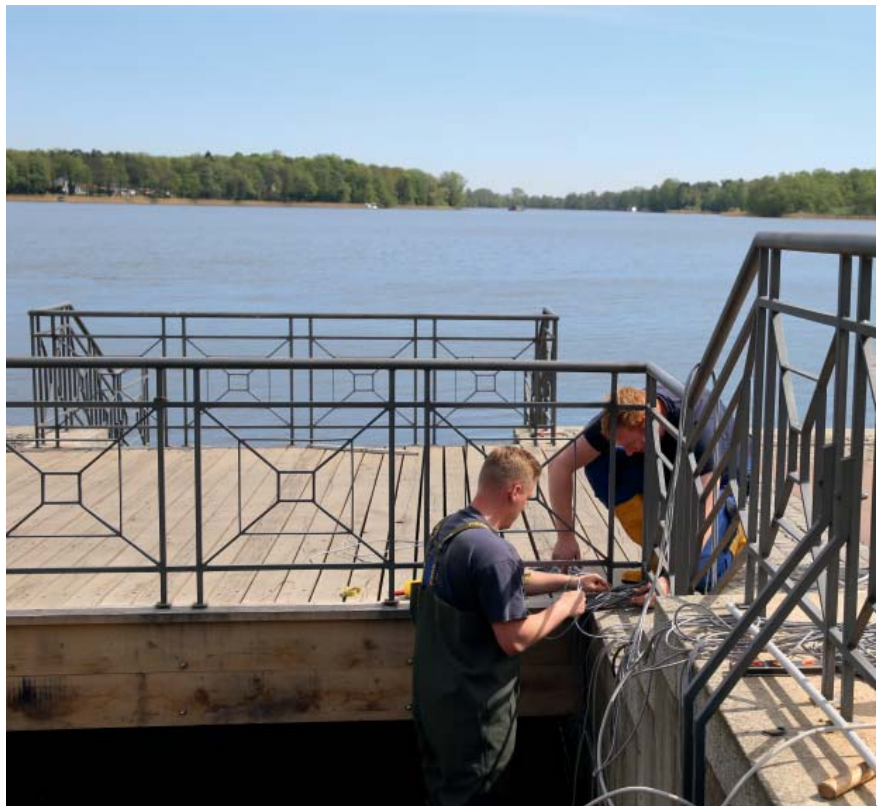
Die Stadtwerke-Elektroniker Dennis Schier (links) und Sven Jahn installieren eine indirekte LED-Beleuchtung in der Klappgrabenmündung.
