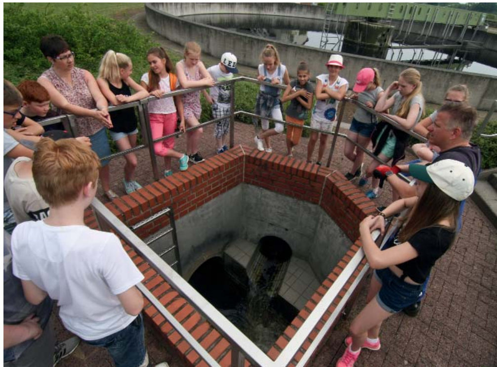
Am Ziel: Hier verlässt sauberes Wasser das Klärwerk.
