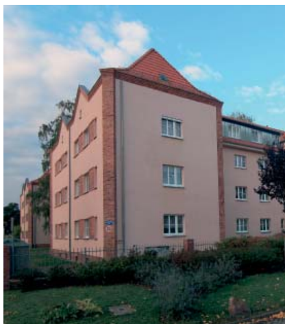
Neuzugänge – hier in der Fehrbelliner Straße – wurden saniert.
