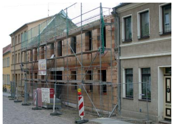
2007: Lückenbebauung in traditioneller Bauweise in der Seestraße 4.
